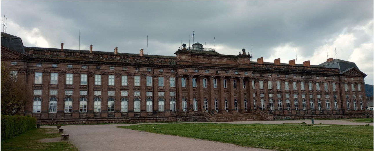
FIGURE 12 : VUE SUR LA FAÇADE NORD DU CHÂTEAU DES ROHAN (SOURCE : EGIS, AVRIL 2023)
