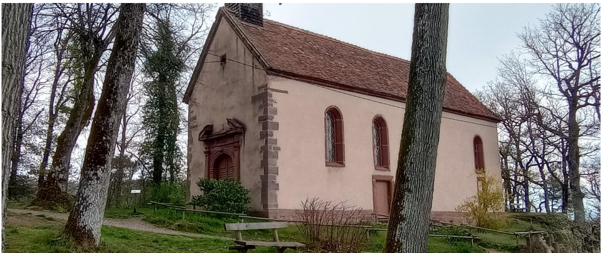
FIGURE 2 : CHAPELLE SAINT-MICHEL (SOURCE : EGIS, AVRIL 2023)
