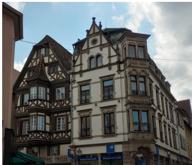
FIGURE 20 : VUE SUR LA FAÇADE D'UNE MAISON AU 96 GRANDE-RUE INSCRIT MONUMENT HISTORIQUE (SOURCE : EGIS, AVRIL 2023)
