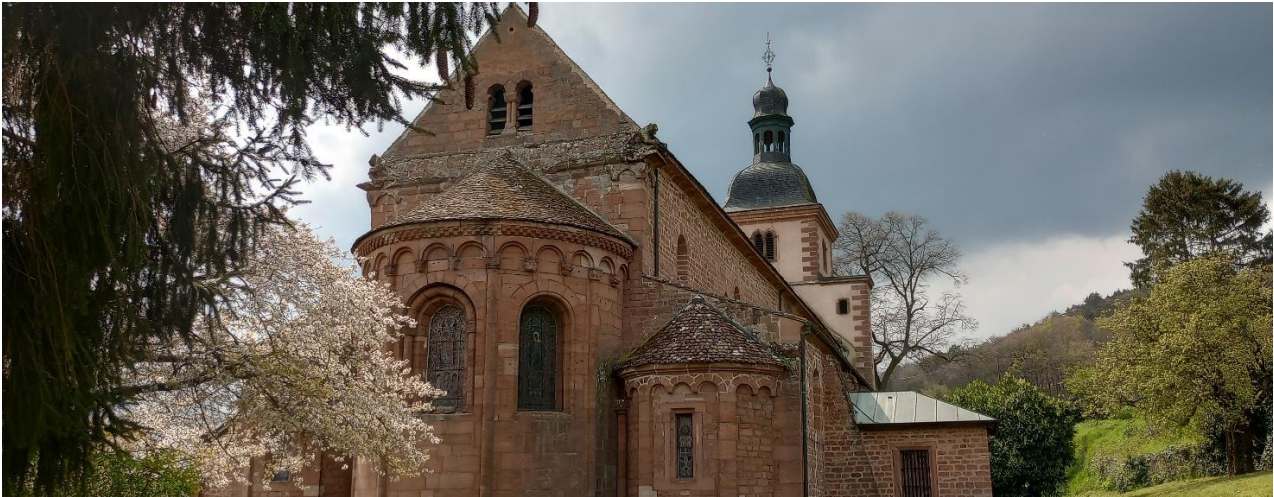
FIGURE 6 : ÉGLISE ABBATIALE À SAINT-JEAN-SAVERNE (SOURCE : EGIS, AVRIL 2023)
