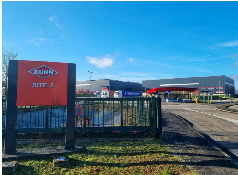
Kuhn souhaite étendre sur dix hectares supplémentaires ses installations industrielles et logistiques en lisière de son implantation actuelle. Plus au sud, à proximité des bâtiments du groupe Fossil, huit autres hectares sont réservés pour la construction du nouveau centre de recherche et développement de l'entreprise. Photo Arnaud Rossignon
